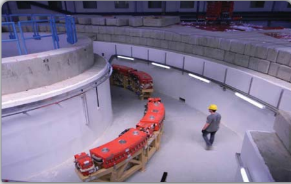
أعمال تركيب في منطقة حلقة التهيئة الأولية (booster)
