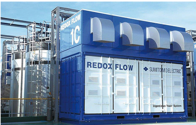
أحد أنظمة تخزين الطاقة باستعمال بطاريات التدفق لشركة سوميتومو
