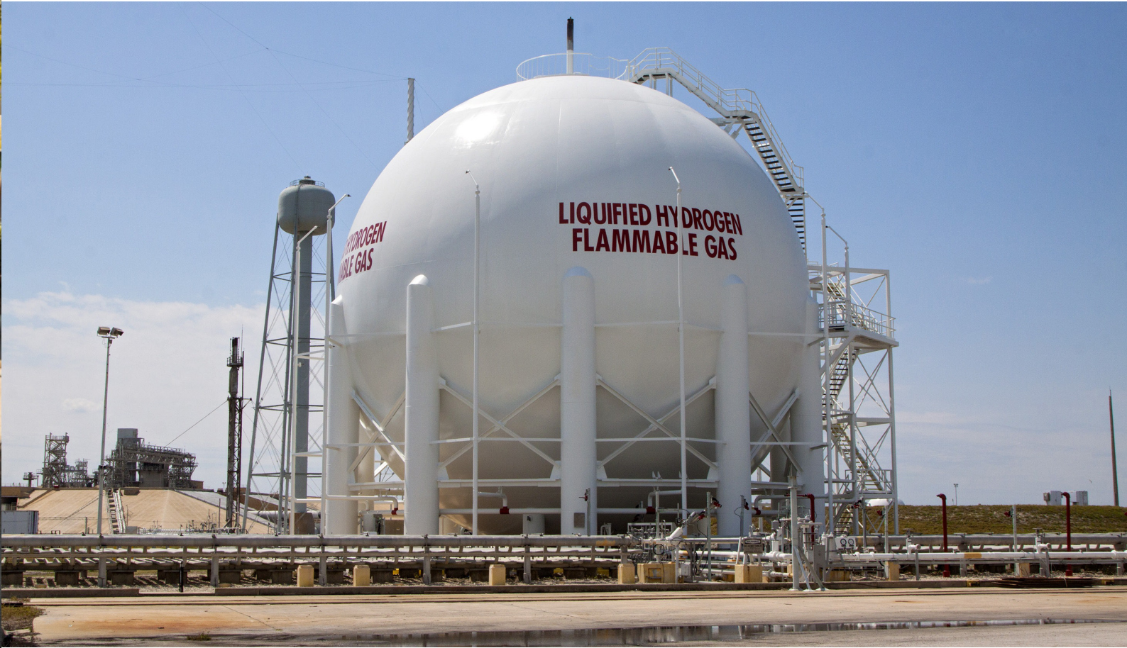
الشكل 7. تخزين الهيدروجين بعد إنتاجه وإسالته في محطة كندي الفضائية.
