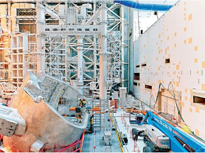
بناؤه على الإطلاق. تسمح الموصلات الفائقة للتيار الكهربائي بالتدفق دون مقاومة؛ مما يسمح للإلكترونات بالتحرك بحرية لخلق مجالات مغناطيسية شديدة. صنعت المغناط من النيوبيوم-القصدير والنيوبيوم-التيتانيوم والمغناط البولويديّة؛ وهي مكونات ITER الوحيدة المصنّعة في الموقع بأقطار تتراوح بين 17 و24 متراً ويصل وزن كل منها إلى 400 طن متري، فهي كبيرة جداً بحيث لا يمكن بناؤها في مكان آخر ونقلها.
