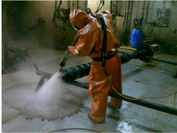
الشكل 4. عملية إزالة الرواسب الحرشفية باستعمال الماء المضغوط.
