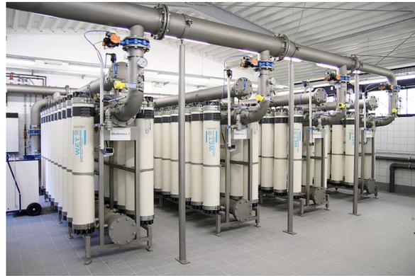
الشكل 5. تنقية ماء الشرب بواسطة الملامسات الغشائية ذات الألياف المجوّفة المسامية بقدرة إنتاج 300 متر مكعب/الساعة في إحدى محطات التنقية.
