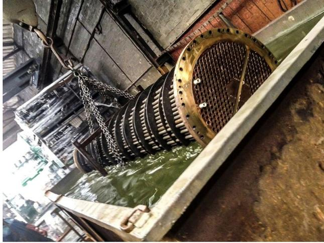
الشكل 7. تنظيف المعدات الملوثة بالمواد الكيميائية.
