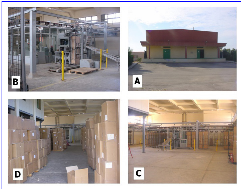
الشكل 13. محطة التشعيع الغامي الموجودة في قسم تكنولوجيا الإشعاع (A): بناء محطة التشعيع (B): غرفة التحكم والمراقبة، (C): توضع المواد المراد تعريضها للأشعة ضمن السلال على السير الناقل، (D): صالة الإنتاج (لتخزين المنتجات المراد معالجتها بالأشعة).
